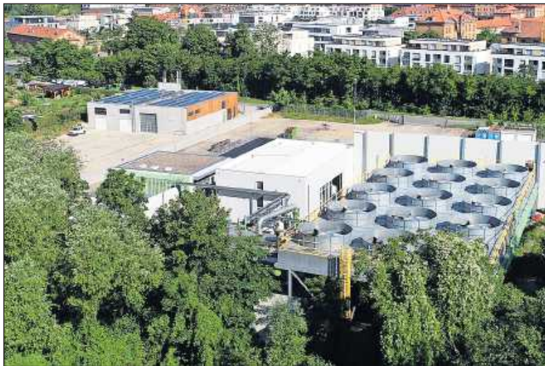
Das Geothermiekraftwerk ist in Landau seit Jahren umstritten. ARCHIVFOTO: VAN
